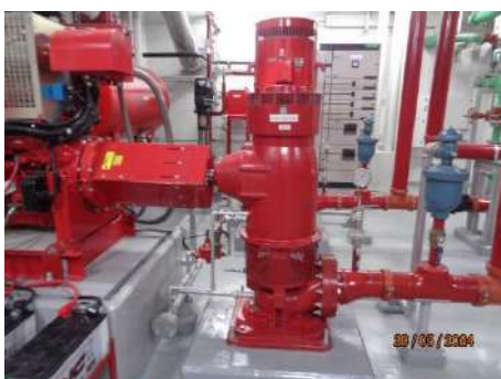
ภาพที่ 2.2-31 เครื่องสูบน้ำดับเพลิงแบบดีเซล
