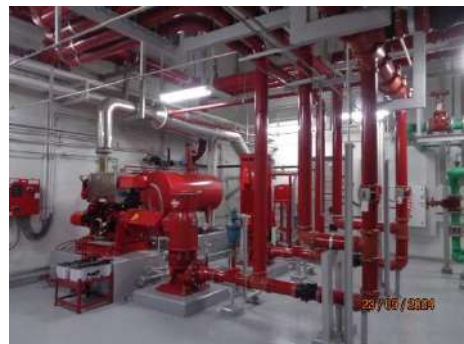
ภาพที่ 2.2-34 ระบบจ่ายน้ำดับเพลิง (Sprinkler System)
