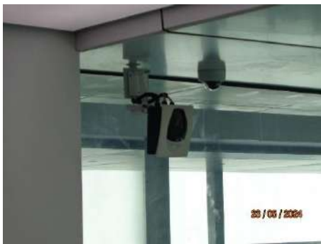
ภาพที่ 2.2-60 อุปกรณ์ตรวจจับควันชนิดลำแสง (Project Beam Smoke Detector Receiver)
