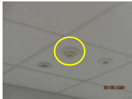
ภาพที่ 2.2-29 เครื่องตรวจจับความร้อน (Heat Detector)
