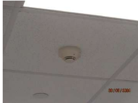
ภาพที่ 2.2-27 เครื่องตรวจจับควัน (Smoke Detector)
