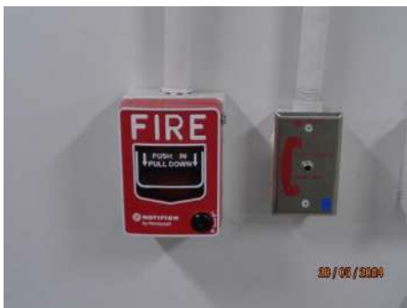
ภาพที่ 2.2-40 อุปกรณ์แจ้งเหตุด้วยมือ (Manual Pull Station)
