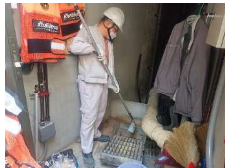
ภาพที่ 2.2-16 บ่อตรวจคุณภาพน้ำก่อนระบายออกนอกโครงการ
