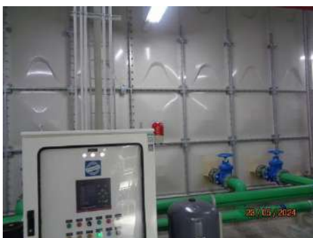
ภาพที่ 2.2-17 ระบบสูบน้ำในอาคาร/ถังสำรองน้ำในอาคาร
