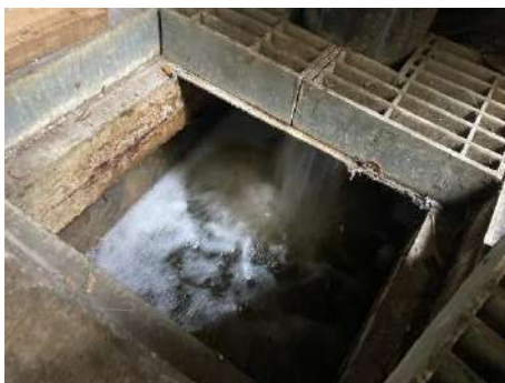
ภาพที่ 2.2-16 บ่อตรวจคุณภาพน้ำก่อนระบายออกนอกโครงการ
