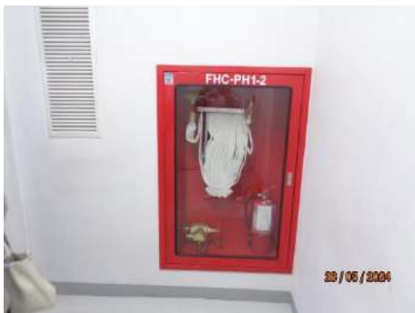
ภาพที่ 2.2-35 ตู้เก็บหัวฉีดน้ำดับเพลิง
