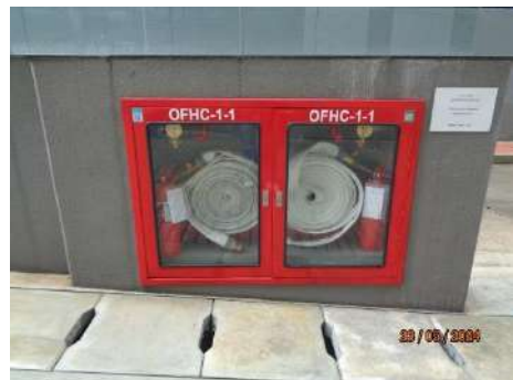
ภาพที่ 2.2-35 ตู้เก็บหัวฉีดน้ำดับเพลิง
