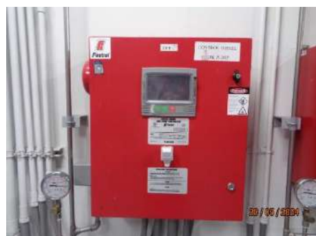
ภาพที่ 2.2-31 เครื่องสูบน้ำดับเพลิงแบบดีเซล
