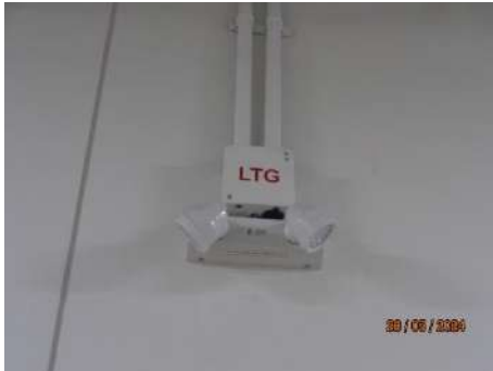
ภาพที่ 2.2-26 ระบบไฟฟ้าฉุกเฉิน
